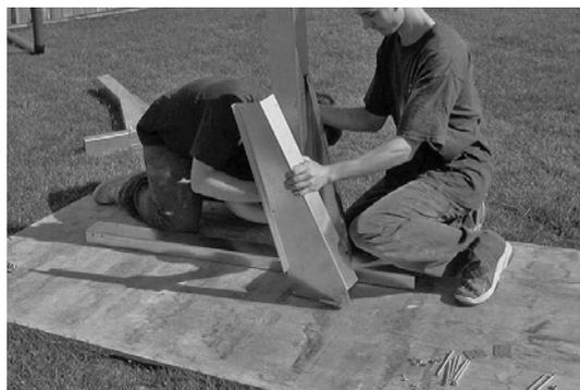
**1.2.5 :** Tutti i fori devono essere allineati a questo punto, imbullonate i componenti come mostrato in figura, ricordandosi di inserire, su entrambe i lati dei rinforzi, le piastrine a 3 fori utilizzando le viti  $\varnothing 8 \times 125$  mm con relativi dadi sulle canaline e  $\varnothing 8 \times 115$  mm per i fori sul montante.
