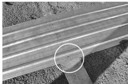
**1.5.4.4:** Una volta che tutte le piastre vengono fissati alle canaline, le piastre devono sovrapporsi. Fissare le piastre tra loro utilizzando tre 6 x 20 viti in ciascuna area di sovrapposizione.
