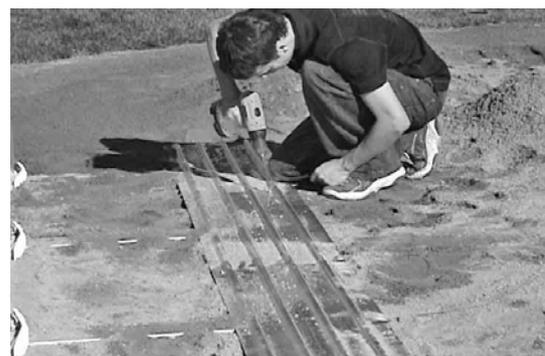
**1.5.4.5:** Se i fori non si allineano, **non praticare dei fori!** Verificare l'allineamento delle strutture in acciaio.
