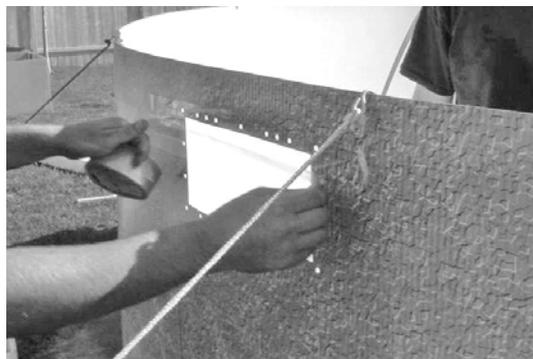
**5.2.4** Inserire il tubo dell' aspirapolvere per pochi centimetri nel foro per il ritorno dell'acqua. Ciò avrà l'effetto di aspirare l'aria e facilitare il processo di rimozione delle pieghe e delle grinze.
