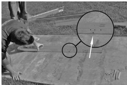
**1.2.3 :** Far scorrere il montante in acciaio sulla canalina superiore facendo attenzione che i fori siano allineati. L'apertura del montante in acciaio deve essere rivolta verso la parte più lunga della canalina superiore.
