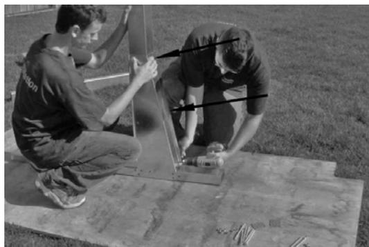
**1.2.7:** Al fine di garantire che il montante in acciaio ed i le canaline siano ad angolo retto durante il montaggio, spingere le estremità del montante in acciaio sulle canaline e stringendo i bulloni nello stesso momento. In primo luogo, stringere i bulloni delle canaline, mantenendo una buona pressione. Stringere poi le viti sul montante.
