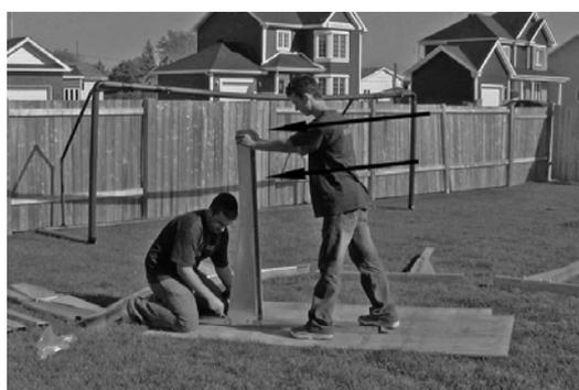
**1.2.8 :** Inserire una piastra superiore di acciaio sulla parte superiore di ogni montante.
