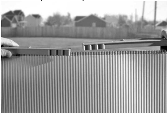
**5.2.2 – B2** Sovrapporre il rivestimento nella parte superiore della parete e mantenerlo in posizione inserendo la protezione in resina.
